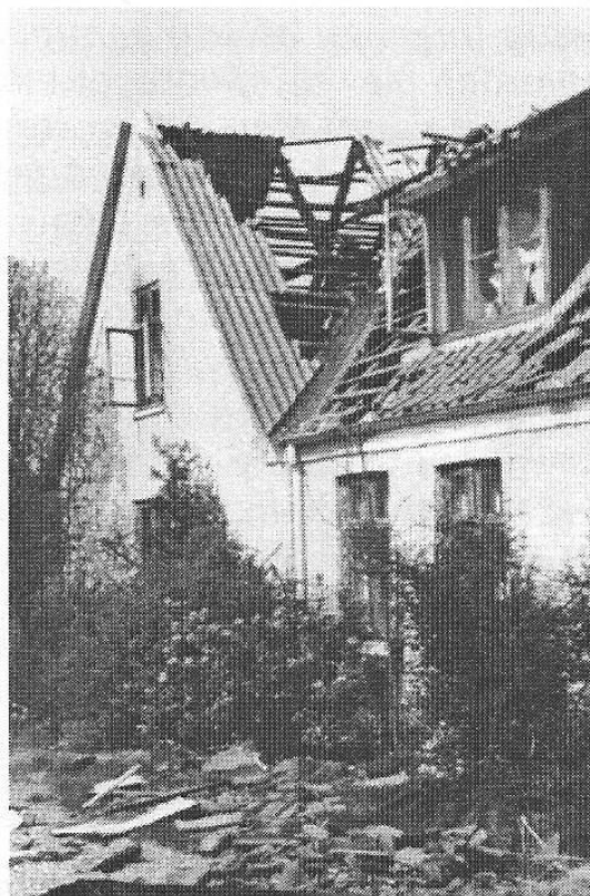
Det gule hus efter branden 1981.
