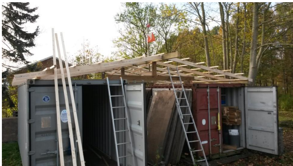
Lægter og spær er monteret og der er klar til rejsegilde.
