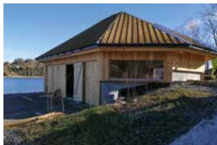
Gapahuken er ferdig utvendig.
