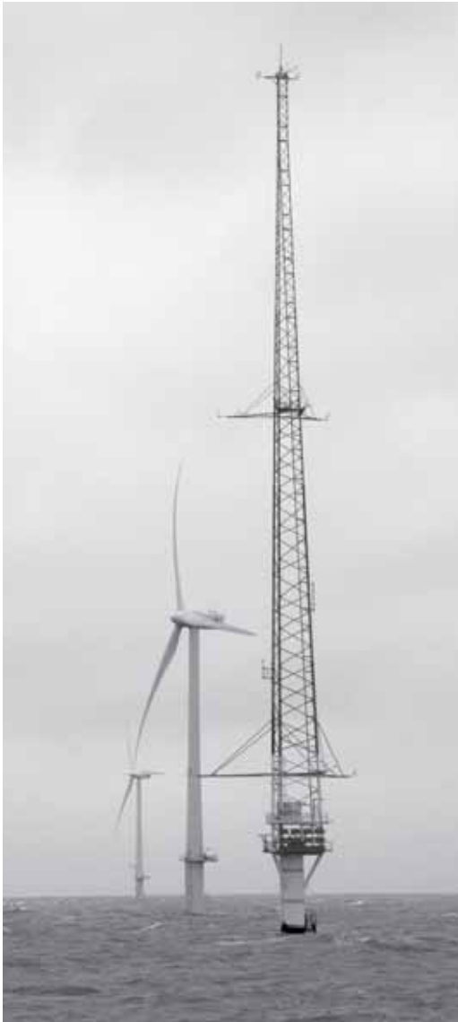
Figure 7 Meteorological mast NoordzeeWind. Photo S. de Jong, Rijkswaterstaat Noordzee.
