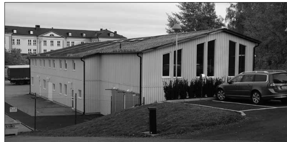
Den nyrenoverade byggnaden sedd från väster. I bakgrunden kasern I. Foto: Fastighetsenheten.
