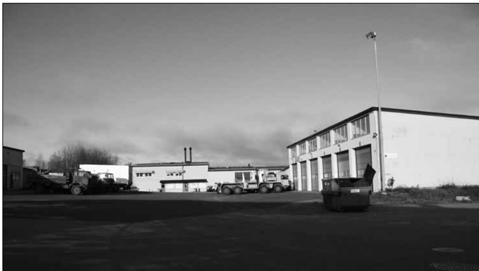
Dagens motorområde. Från att förr ha varit inte stort mer än en "mack" har motorområdet kontinuerligt utvecklats även om inga större byggnader har tillförts de senaste tio åren. Teknikhallen till höger, i fonden teknikhuset och motorförrådet.
