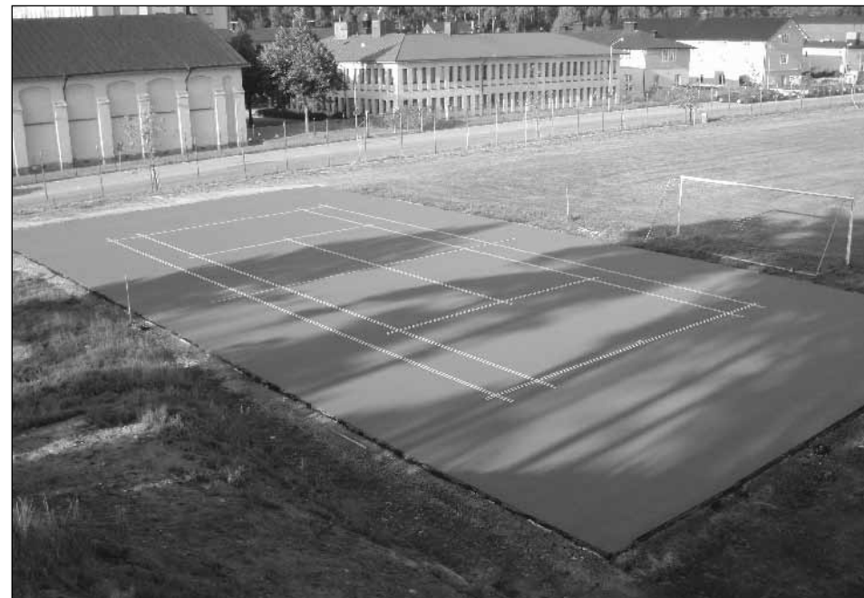
Nya tennisbanans placering är öster om fotbollsplanen. Bilden är från augusti 2006 och varken spelnet eller yttre inhägnad är ännu på plats. Målning av linjer på grön gummiasfalt pågår. Foto: Jarl Wallefors.
