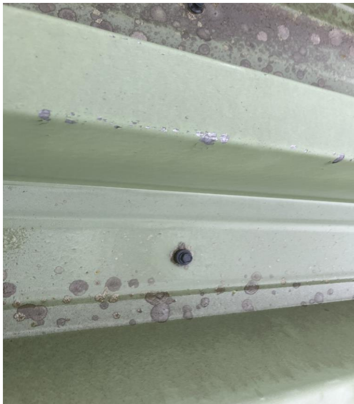
"Farmarskruvar" skruvade i mitten på takytorna, bild 4.
