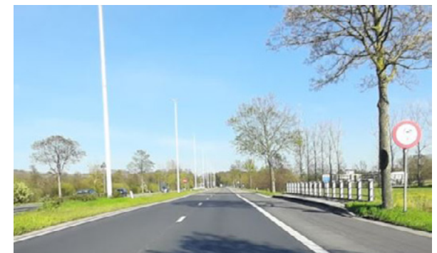
Figuur 6: Dwarsdoorsnede Universiteitslaan N702 (brug Demer) richting Hasselt (links) en richting Genk (rechts)
