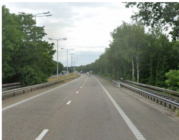
Figuur 45: Dwarsdoorsnede E314: brug aan camping Kikmolen richting Genk (links) en richting Maasmechelen (rechts)
