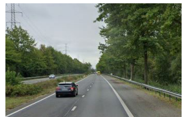
Figuur 20: Dwarsdoorsnede Boudewijnlaan N702: segment brug Havenlaan - Westerring (N76) richting Hasselt (links) en richting Genk (rechts)
