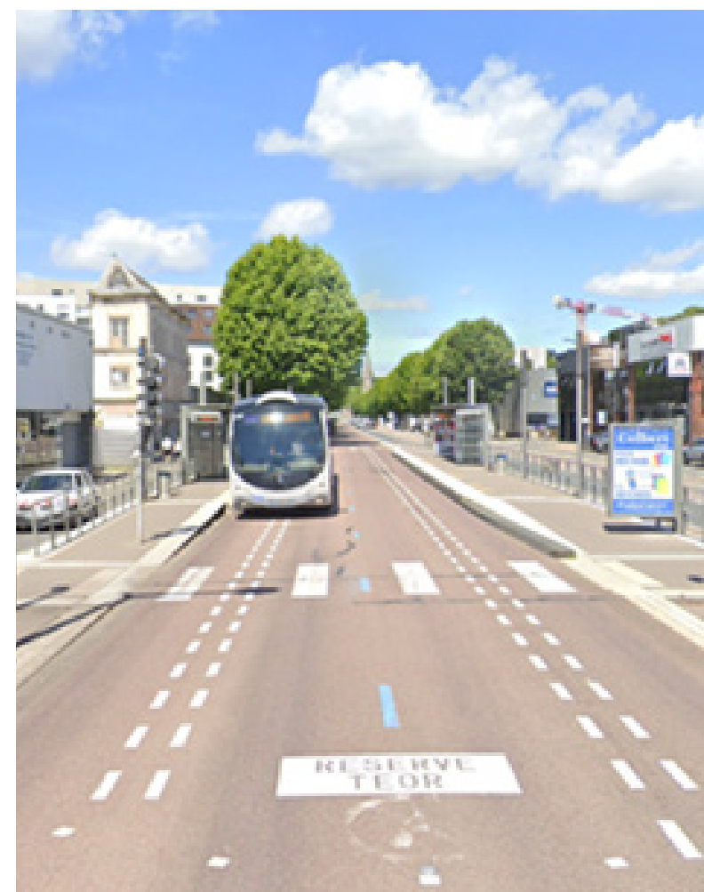
[TEOR halte op de Avenue de Mont Riboudet, Rouen. Let op de typische belijning voor het geleidingssysteem, de halfrechtvormige versmalling naar het perron toe, de aangepaste perronhoogte, en de camera geïntegreerd in de bus boven de voorruit. Beeld: Google Streetview.]
