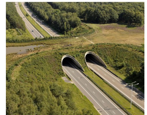
Ecoduct Kikbeek (Maasmechelen) werd in 2005 gerealiseerd over de E314 ter ontsnippering van het NPHK
