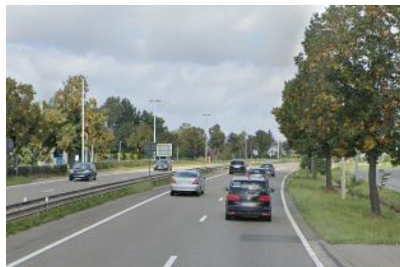
Figuur 24: Dwarsdoorsnede Westerring N76: segment Meeënweg - Zuiderring richting Hasselt (links) en richting Genk (rechts)
