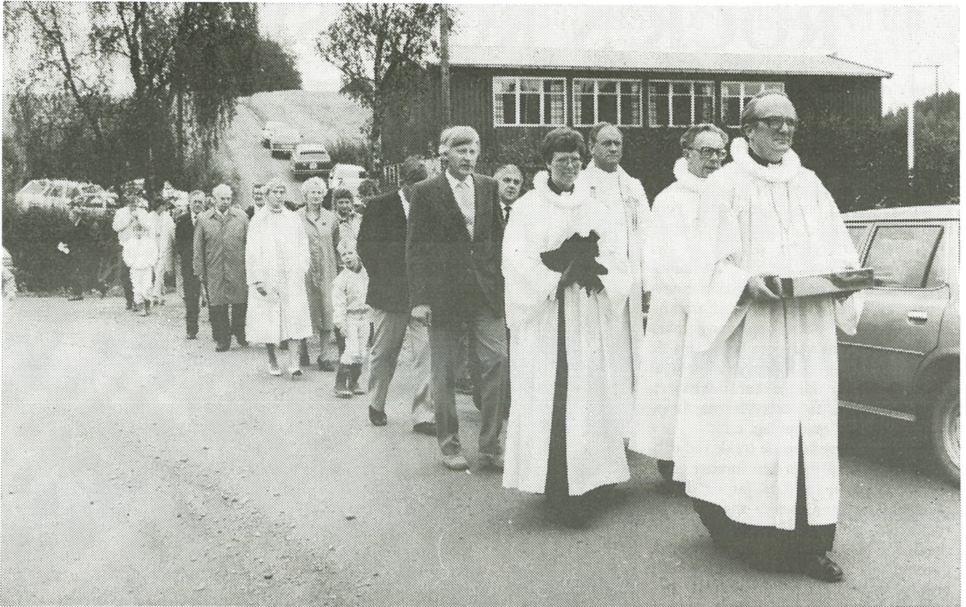
Etter gudstjenesten i samfunnshuset ledet biskop Bremer prosesjonen til byggegraven hvor grunnsteinen ble lagt ned.
