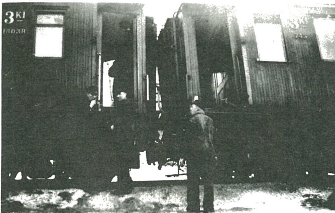
T.v.: I tog 2453 sporet omtrent annenhver vogn av med en boggi hver, vognene klatret på hverandre og det oppstod skader gjennom hele togsettet. Bildet gir forøvrig anledning til å studere endel vogn tekniske detaljer. Man kan f.eks. se at toalettet i vogn 745 har nedfellbart vindu, og at stiggrettene på den ene vognen er av stål, mens de på den andre er av tre. Foto i Jernbanemuseets samling. T.h. Togstammen i ulykkestoget 2453, med halve taket fra den tilintetgjorte motorvognen i forgrunnen.
