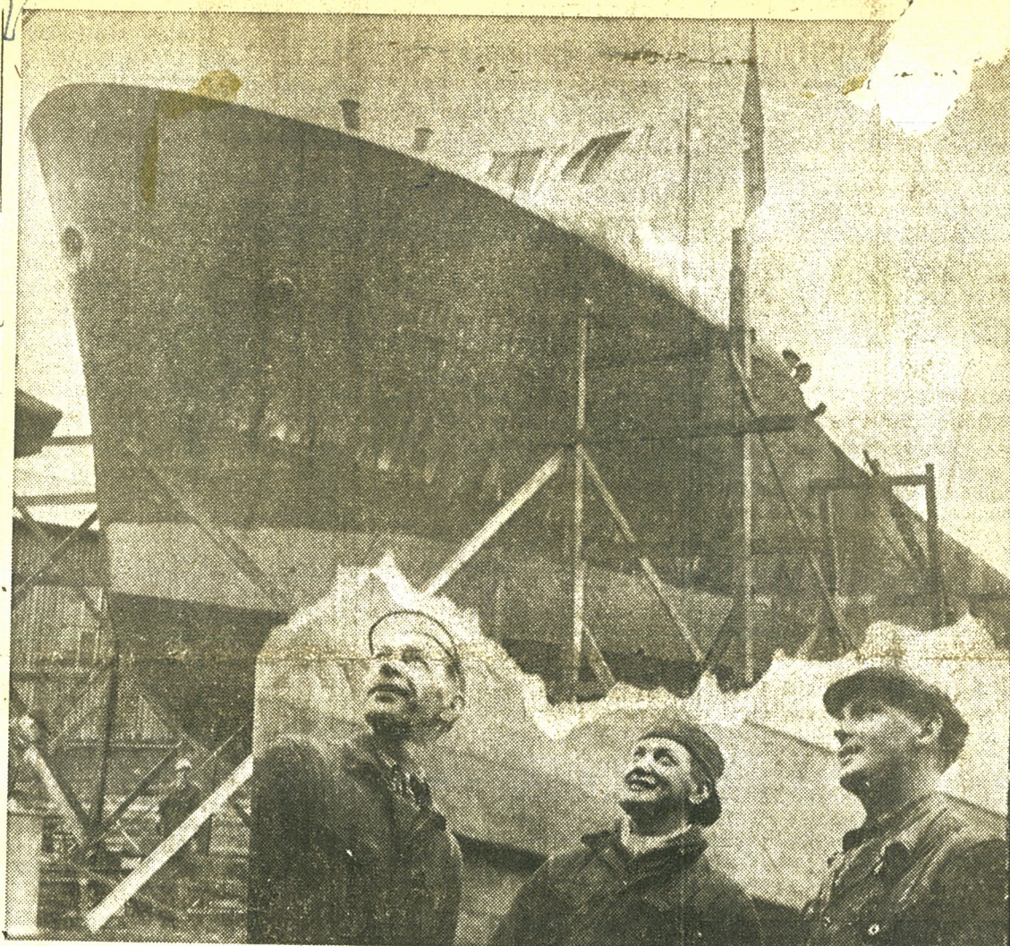
Dette bildet b'è tatt like før stabelavsløpningen i formiddag. Øverst ligger båten klar, og under sees tre av arbeiderne som har vært med under byggingen. Det er fra venstre: Sverre Engen, Werner Kristoffersen og Knut Rokkones.
