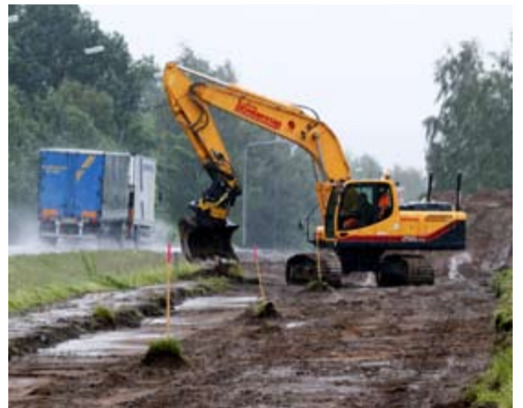
I november eller december ska den nya sträckningen av gång- och cykelvägen mellan Aspö och Lillegårdsrondellen stå klar.
