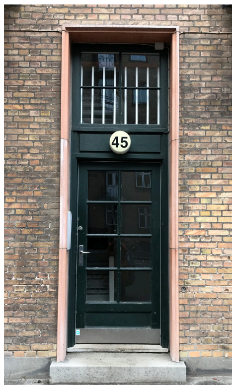
Eksisterende hoveddøre renoveres og energioptimeres
