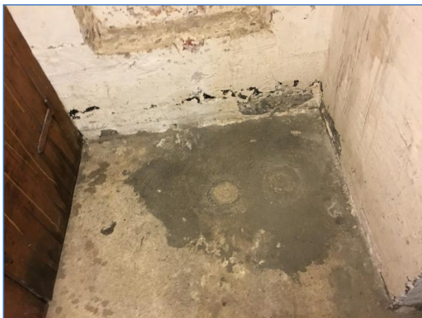
Kældervægge og gulv
