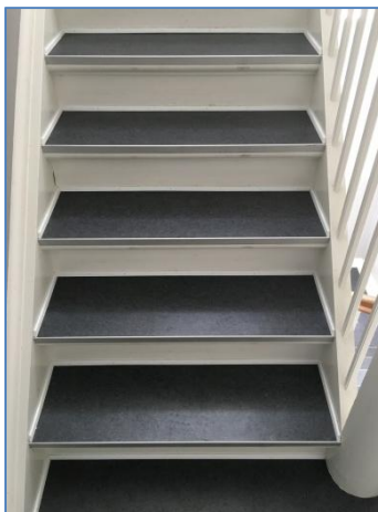
Trappenedløb på hovedtrappe
