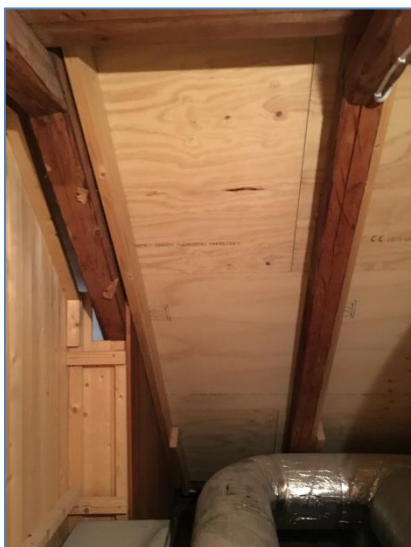
Fast undertag og spær-forstærkninger
