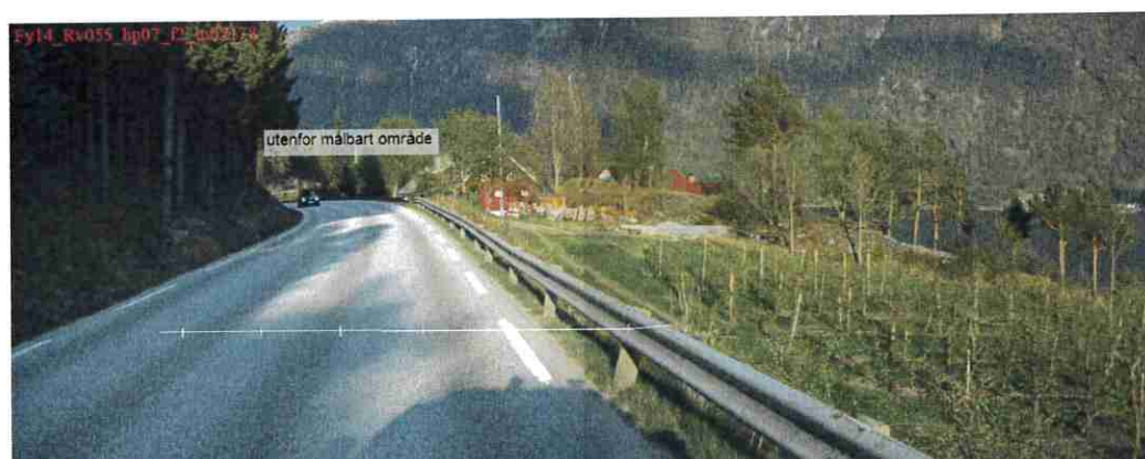
Figur 14 Bildet viser strekning før venstrekurve, ulykken skjedde i neste kurve. Kilde Statens vegvesen
