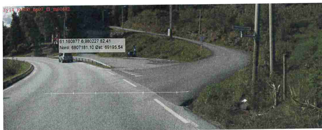
Figur 9 Bilde viser området der kurven begynner å knipe. Statens vegvesen
