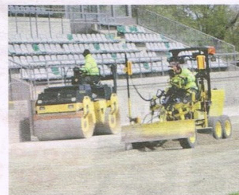
Banorna jämnas till för att sen läggas asfalt på, därefter den nya gummimattan, och sen skall linjerna målas för att friidrottarna skall återfå sin idrottsplats och nya underlag.
