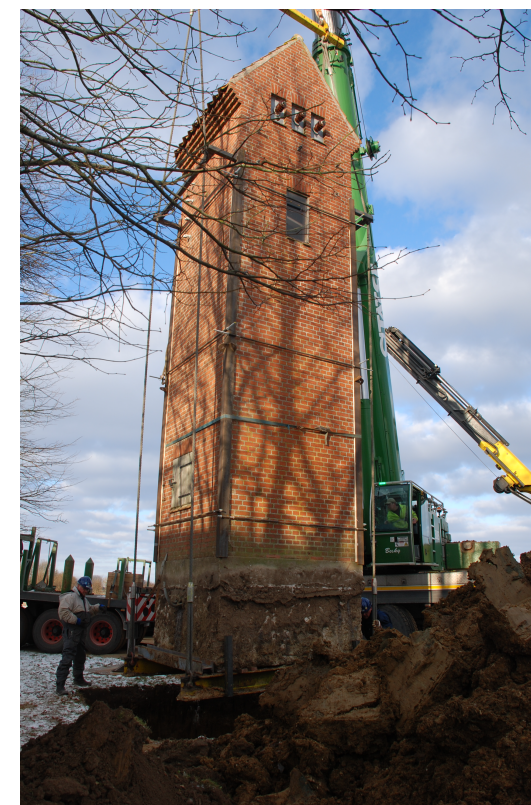
Transformertårnet blev flyttet i ét stykke til museet. Det tog knap 24 timer, da man både stødte på strømkabler og et fundament, som ikke var stabilt. Flytningen foregik under hårde forhold i 15 graders frost og strid østenvind. Men til sidst lykkedes det at få tårnet placeret, hvor det nu står.
