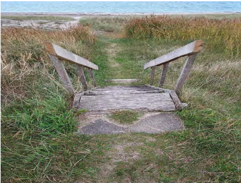
Eksisterende trappe som der søges lovliggjort – er placeret ved punkt 6 på figur 4 ovenfor. Indsat fra ansøgning.
