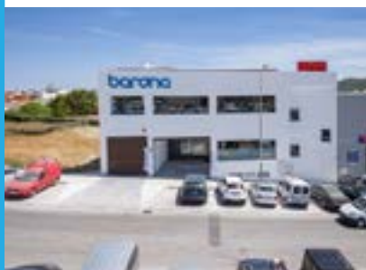
Baronan uudet toimitilat rakennettiin alusta saakka toimintaa varten. Ainostaan seinät olivat olemassa ennen remonttia.
