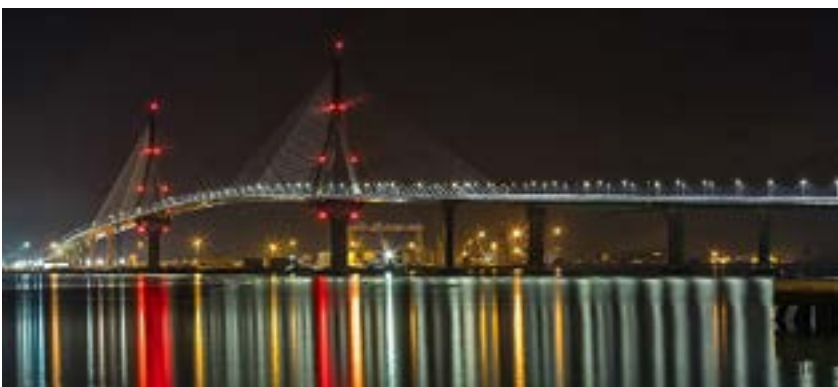
Iltavalaistuksessa silta loistaa komeasti.
