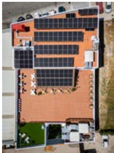
Sähkö uusiin toimitiloihin tuotetaan omavaraisesti aurinkopaneeleilla.
