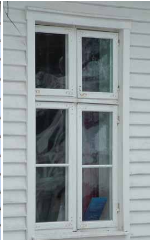
Reparert vindu - Kirkegaten 56
