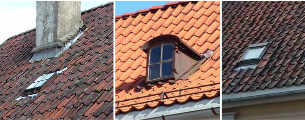
Gamme takluke, takvindu i form av takoppbygg i støpejern og moderne takvindu
