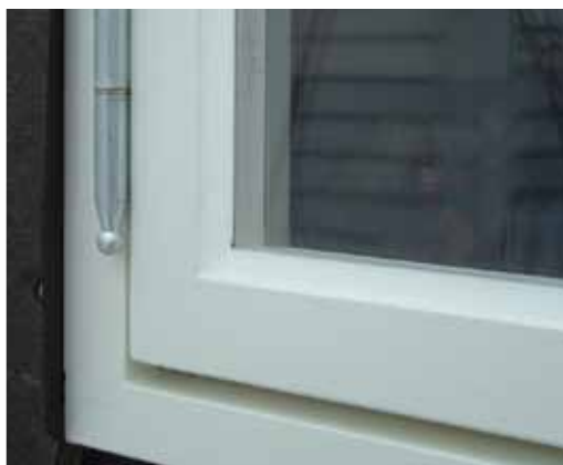
Vindu med enkelt isolerglassvindu satt i kittfals (Isospross)
