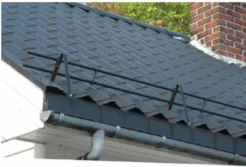
Taktekking av metallplater er uakseptabelt på 1800-talls hus (feil detaljering og feil alderstegn).
