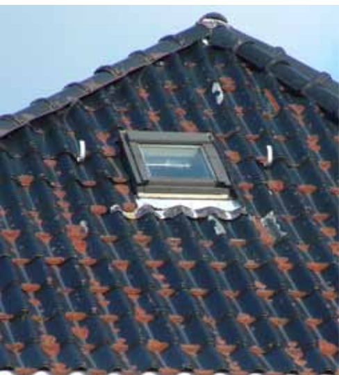
Taktekking av metallplater er uakseptabelt på 1800-talls hus (feil detaljering og feil alderstegn).
