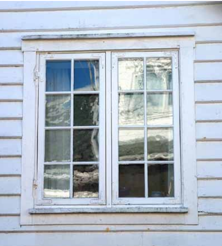
Reparert vindu – Hidragaten 7
