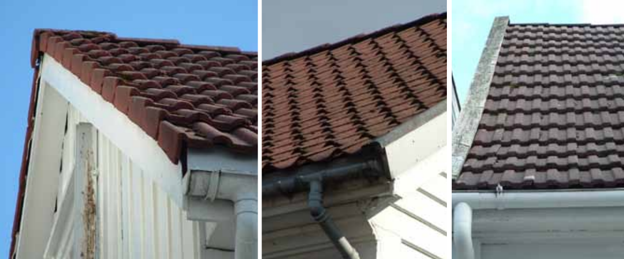
Taktekking av betongstein og takrenner av plast har ingenting på et 1800-tallshus å gjøre. Taket skal ikke avsluttes med kantstein mot gavl, men av solbord (som på bildet til høyre)
