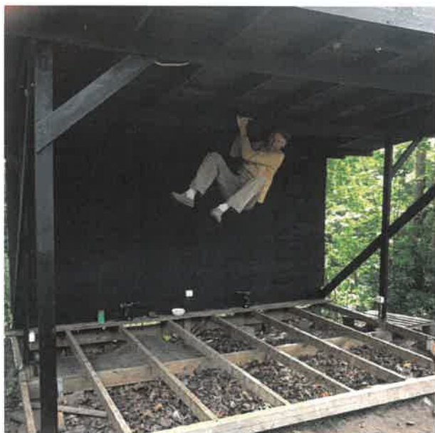
Anders har demonterat det gamla scengolvet.
