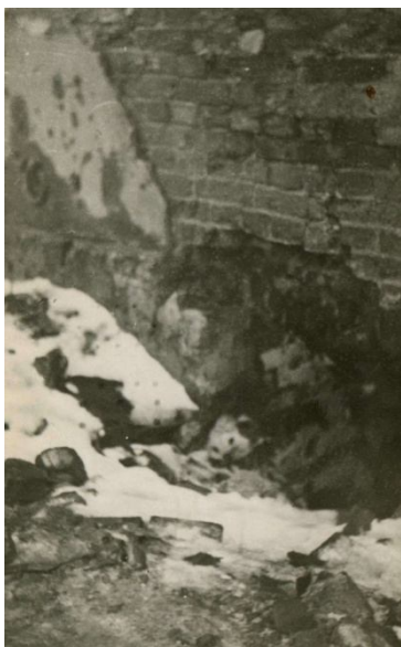
8. ul. Daniłowiczowska - barykadka i okienko piwniczne, przez które wyciągano Edka Kuminka.
