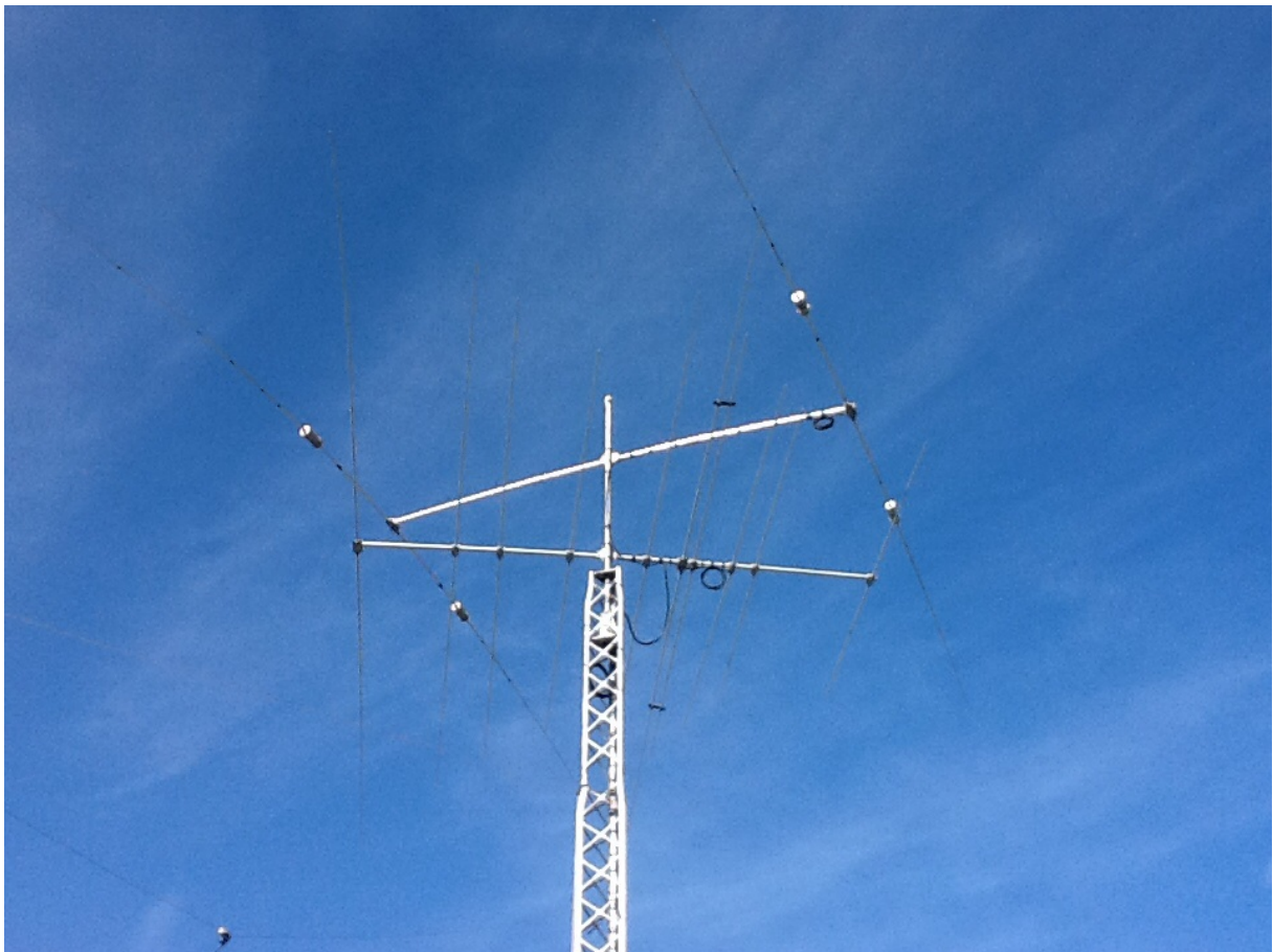
Den undre Yagin är en fem-bandare för 14-30 MHz och den övre en 2-elementare för 7 MHz.
