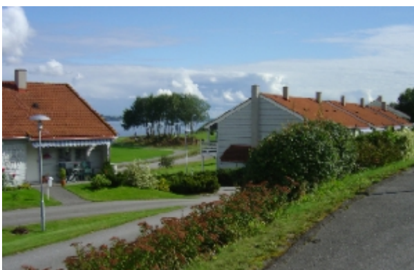
Kjartan Engstu viste oss rundt på Fredevika Borettslag
