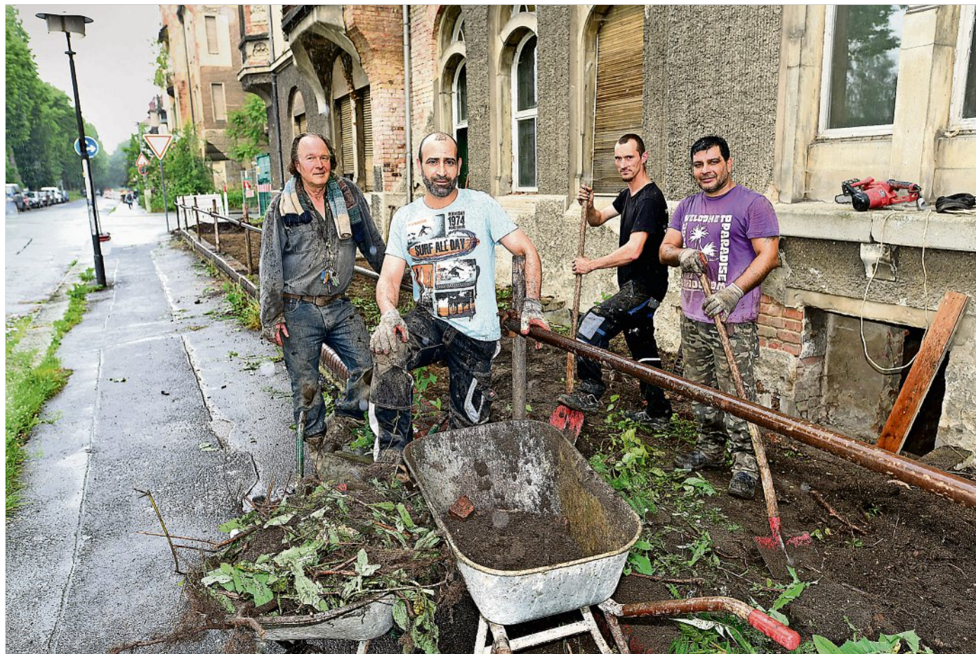
Eigentümer Benjamin Pfefferkorn (li.) mit seinen Mitarbeitern bei Außenarbeiten am Eckhaus.
