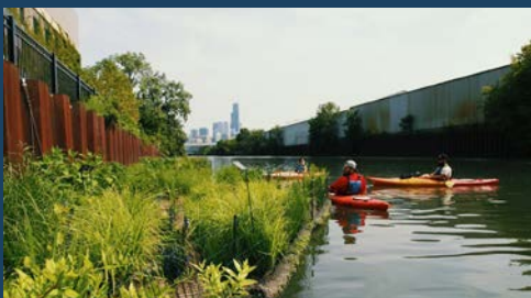
Flydende grønne øer giver nærhed til vandet. Øerne er bygget udenpå spunsvæggen og har adgang via ramper. Wild Mile, Chicago
