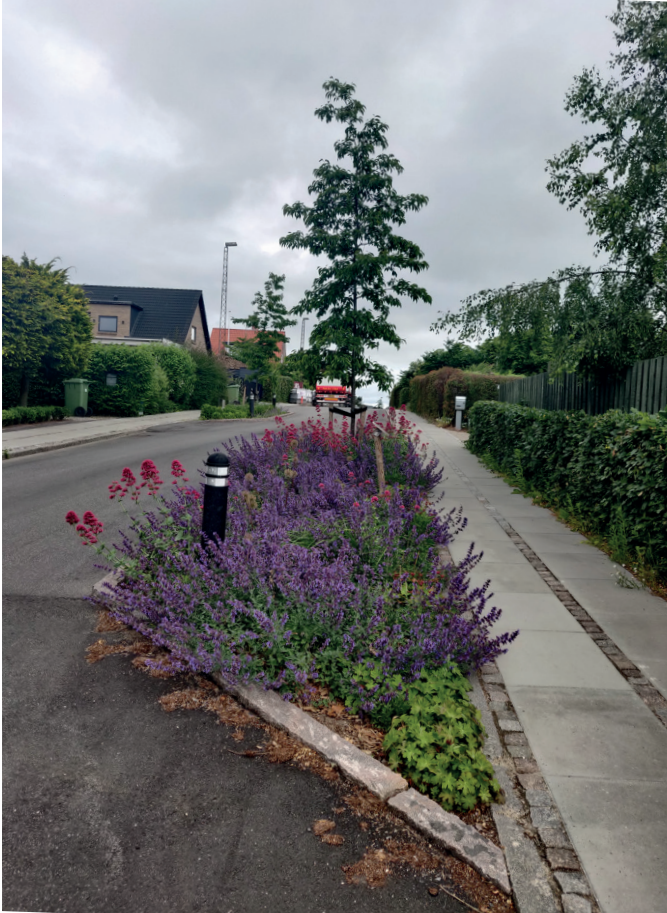
Foto: Regnvandsbedene i Åbyhøj bidrager til et karakterrigt gademiljø med styrket bynatur i synergi med tryggere trafikafvikling
