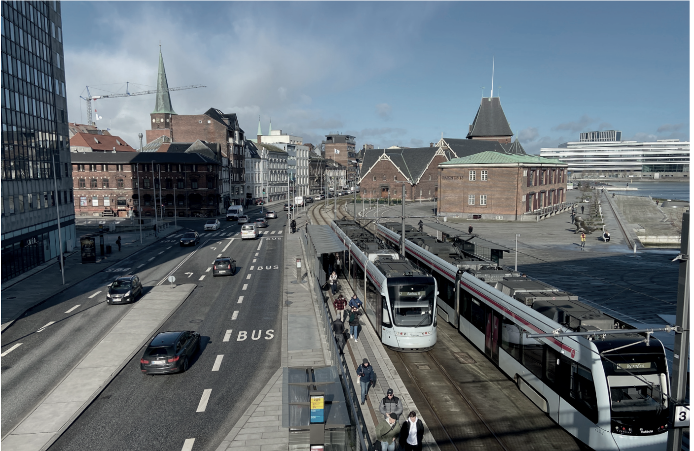
Foto: Letbanen i Aarhus er etableret sammen med Kystvejen der fungerer som en højvandsbarriere på strækningen fra Dokk1 til Skolegyde, og beskytter midtbyen mod forhøjet havvandsstand
