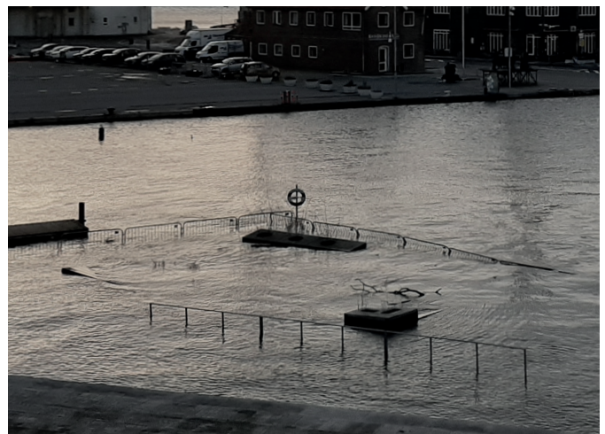
Foto: Høj vandstand i Aarhus Bugt i december 2023. Oversvømmelser af de nedre plateauer omkring Dokk1 og vandstand meget tæt på havnepiers terræn. Slusen blev lukket pga den høje vandstand.
