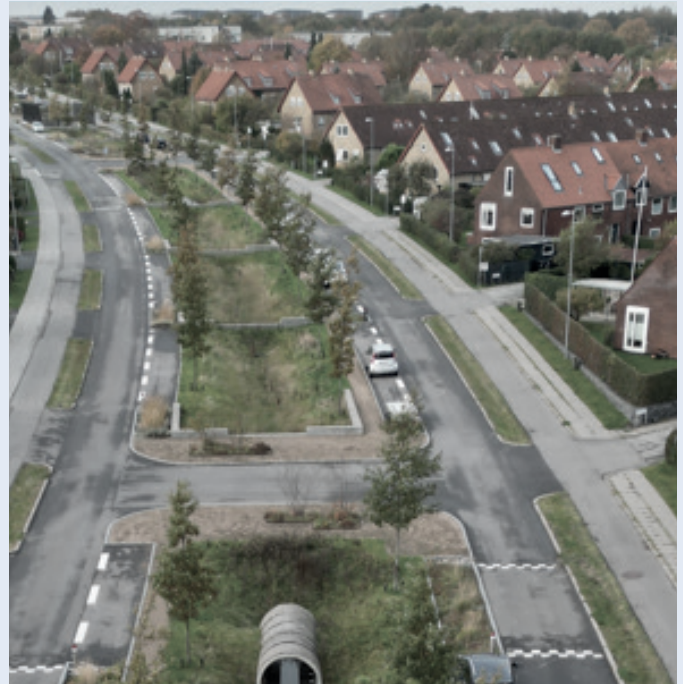
Foto: Vi er godt på vej med klimatilpasning af Aarhus og har i samarbejde med Aarhus Vand udført flere rekreative tilpasningsprojekter. Her ses Risvangen, klimatilpasset gennem skybrudshåndtering i rekreative anlæg.
