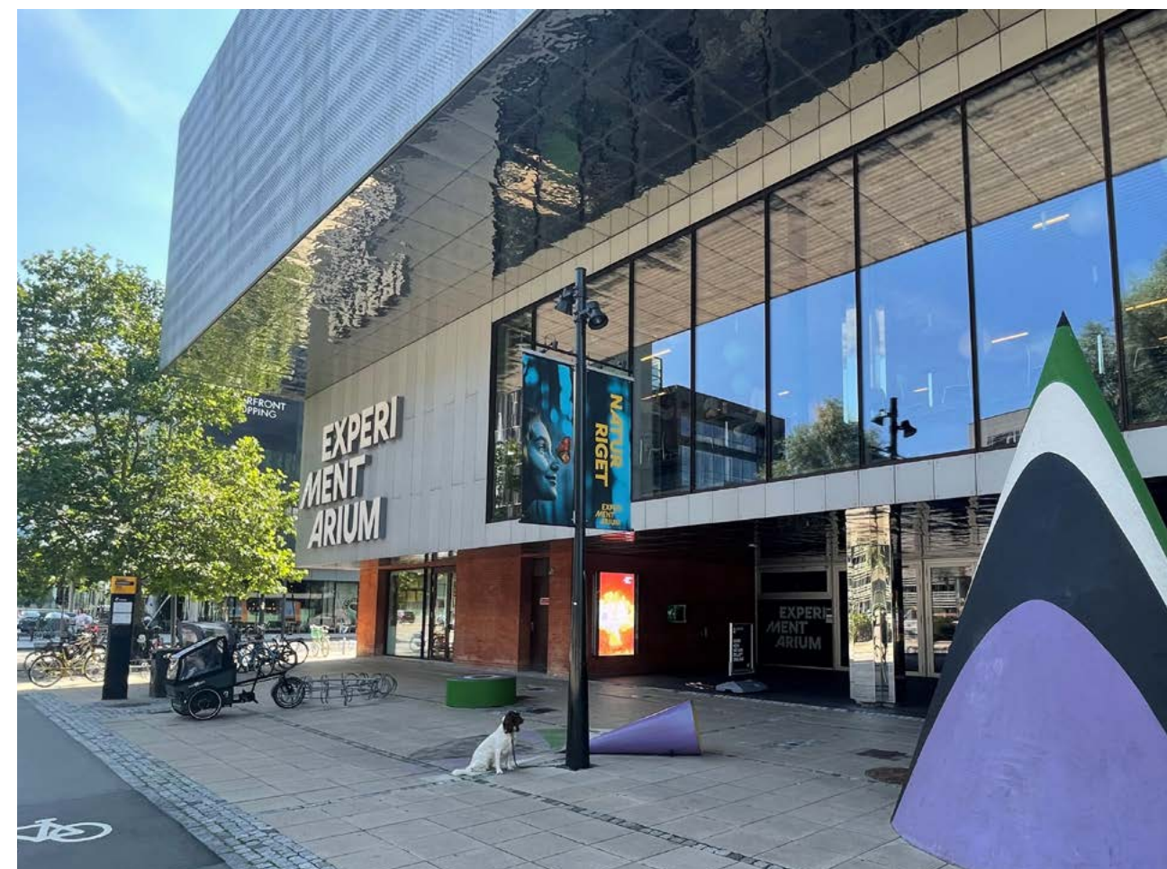
Markant arkitektur med facader og indgangspartier der henvender sig ud mod byrummet
