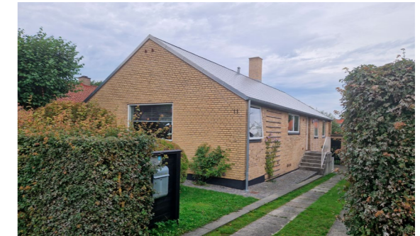
Statslånhus, Skovdalsvej 11. Opført i 1953
