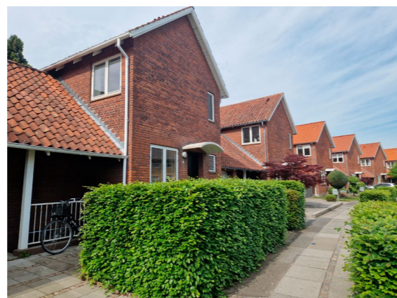
Rækkehuse på Dyrehavevej
