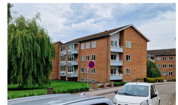
"Pandekagehusene", Uffesvej. Opført i 1953
