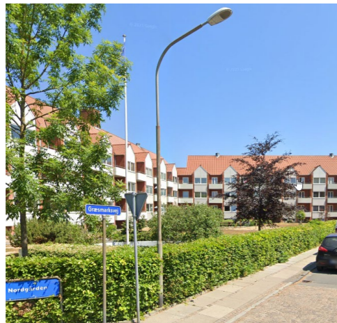
Etageboliger, Nørre Boulevard, ved "Nettogrunden"
