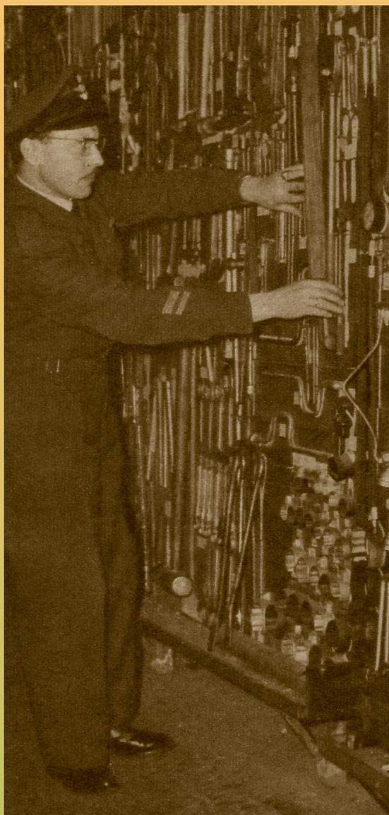
Het atelier Hydraulica houdt zich bezig met het nazicht en het herstellen van de remsystemen van de C-119. Het voert testen uit om de lekken in de onderdelen van het hydraulische systeem op te sporen.
