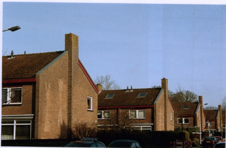
▲ De kopse gevels met baksteen-reliëfs aan de Thorbeckelaan.
