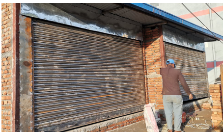
Mur vegger, tinn tak og dør er også ferdig.
