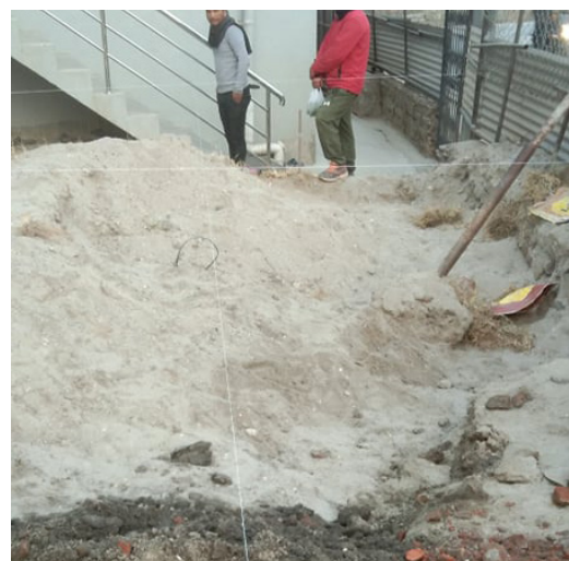
Her måler de med tau for å sette fundamentet til butikkene.
