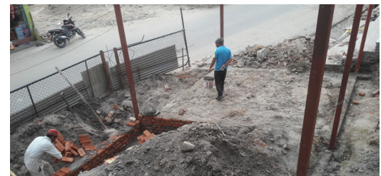
Vi installerer jern stenger slik at bygget skal bli solid.
