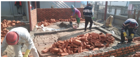
Grunnmuren for de små butikkene er ferdig.
