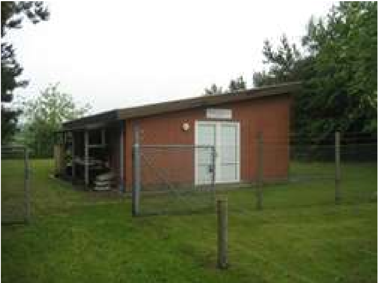
Hvam Vandværk a.m.b.a.
