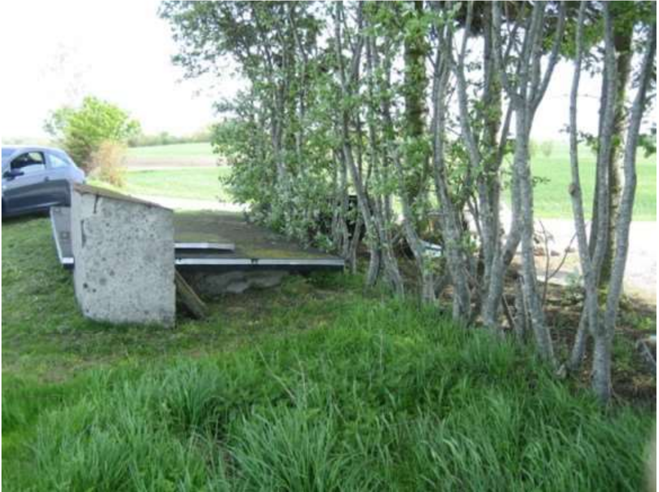
Mammen og Vinkelhedens Vandværk
