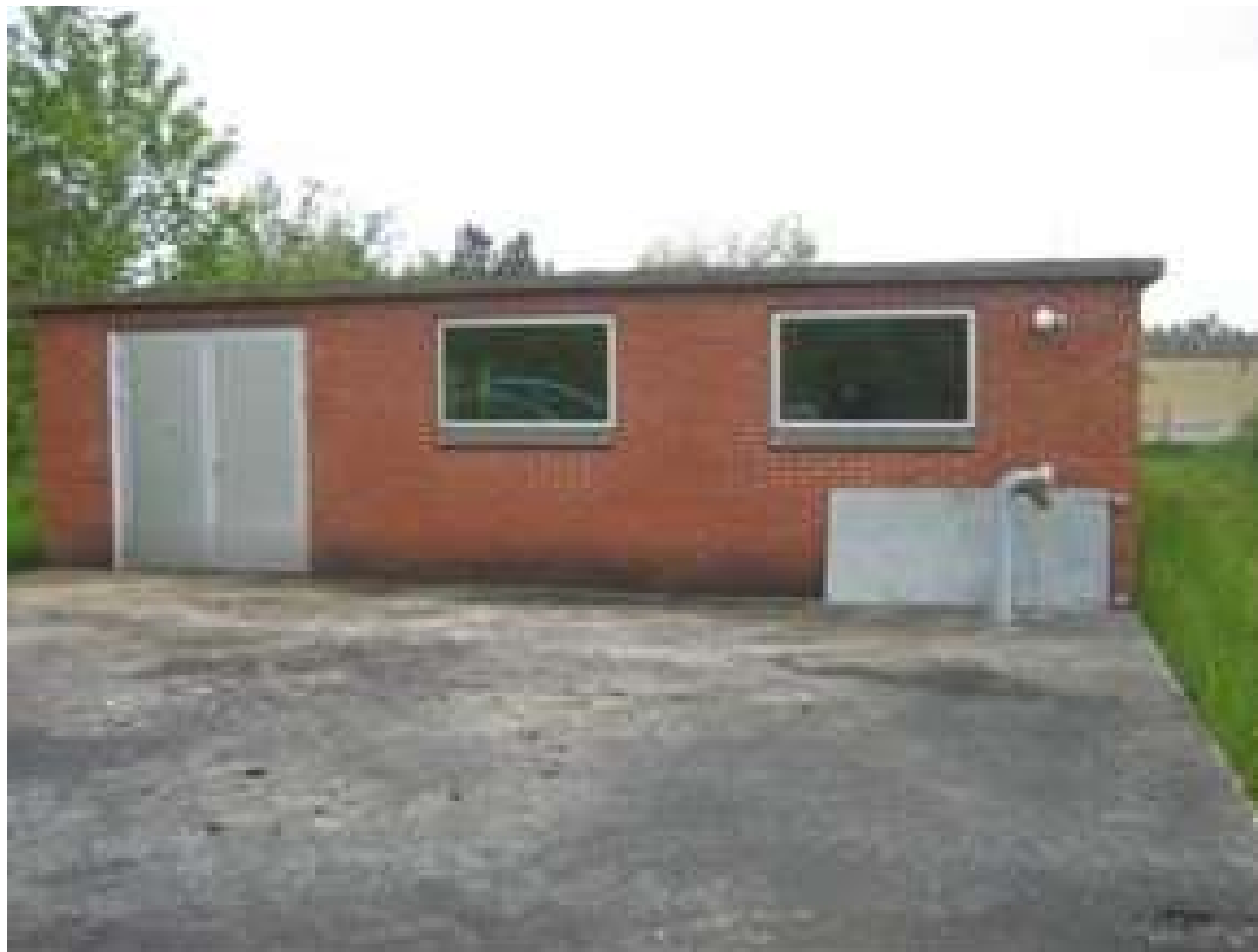
Karup (gl. værk) Vandværk
