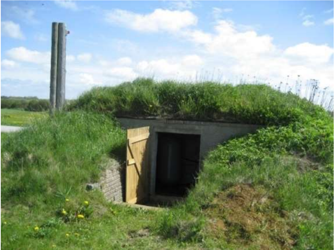
Brandstrup Vestre Vandværk I/S
