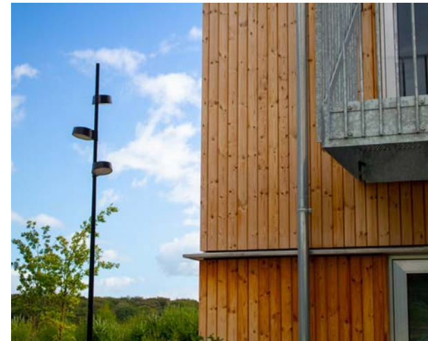
Opførelse af CLT-byggeriet Skousbo i Viby Sjælland
