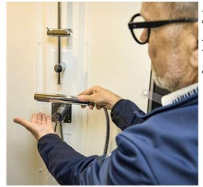
Der Wassertank muss befüllt sein, um die Funktion der Pumpe zu kontrollieren.
