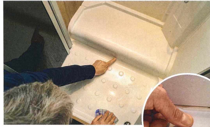
Sieht man nur beim Hinknien: Die Dichtung der Duschtasse ist mangelhaft, wohl schon ab Werk.
