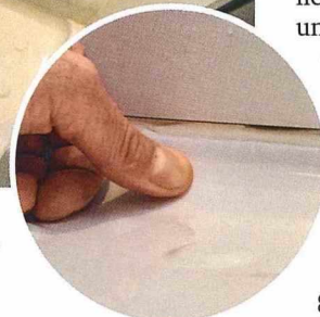
Sieht man nur beim Hinknien: Die Dichtung der Duschtasse ist mangelhaft, wohl schon ab Werk.
