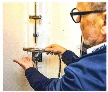
Die Tanks sollten leidlich befüllt sein, um die Funktion der Pumpe zu checken.
