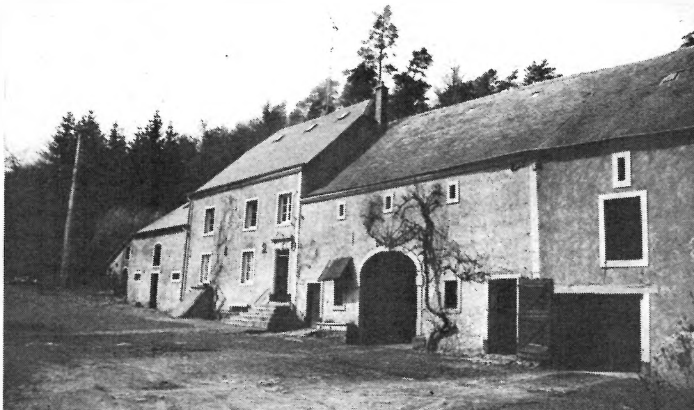
Le moulin de la Platinerie, entre Bonnert et Tontelange (non loin d'Arion). Toit unique mais à plusieurs niveaux, avec croupettes; construction en longueur et relation entre les pleins et les vides sont ici caractéristiques.
