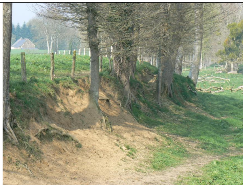
Talus de ceinture ennoyé
