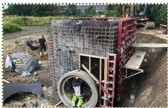
Udløbsbygværk under konstruktion med \varnothing 1400 indgangsledning.
