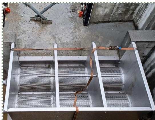
Montage af rist og pumpe i bygværk.
