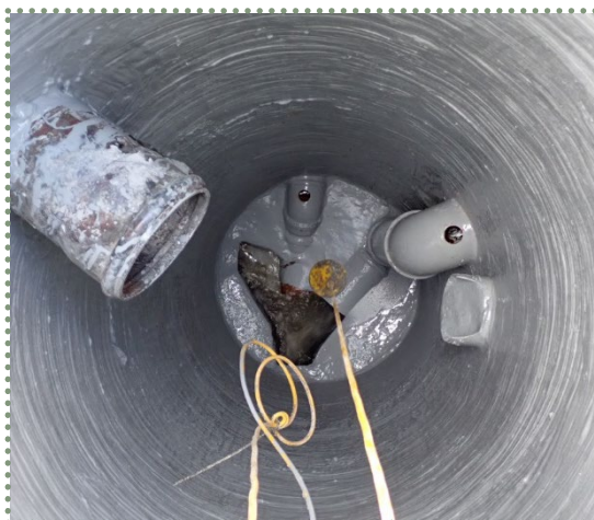
Brønd efter renovering
