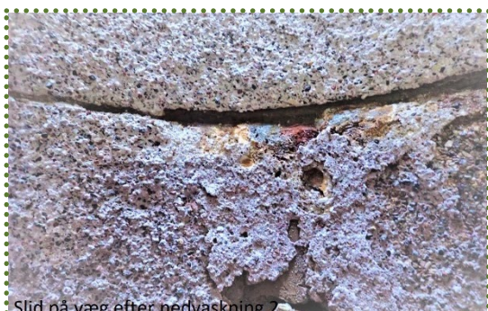
Slid på væg efter nedvaskning.
