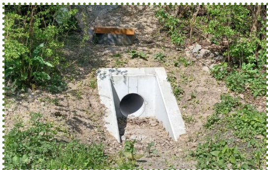
Ny brønd med tilhørende udløb til regnvandsbassin.
