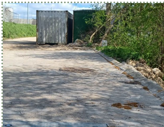
Ø2000 brøndtop udskiftet til et rundt Ø1250 dæksel.
