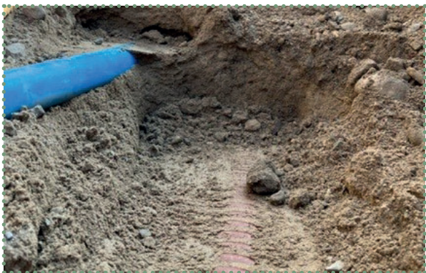
Fylgning af materiale omkring kloak og vandledninger.
