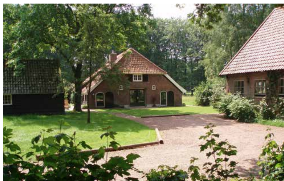
referentie: open erfbebouwing
