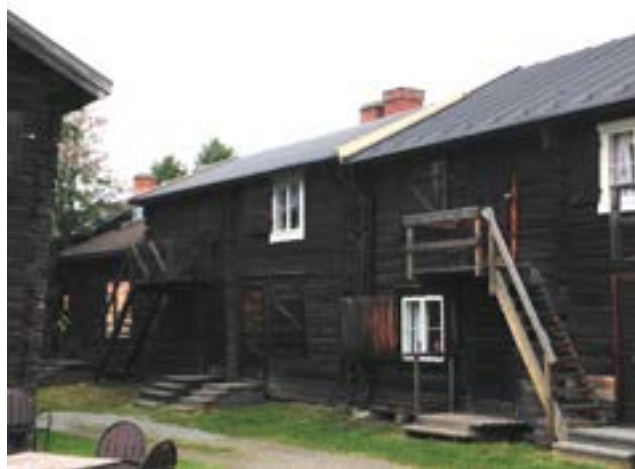
Kammare 425-428, södra fasaden efter åtgärd.
