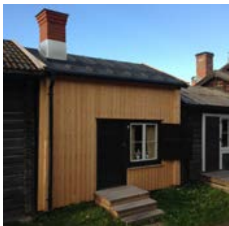
Kammare 127, norra fasaden efter åtgärd.
