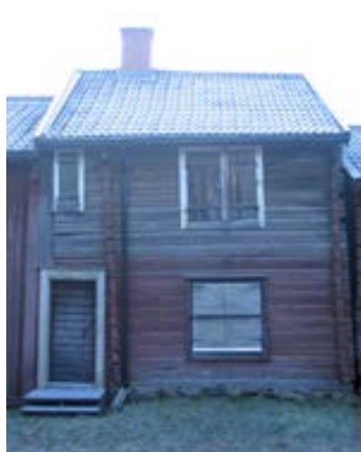
Kammare 86-89, fasad mot norr före åtgärd.
