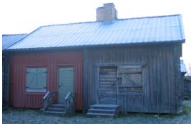
Kammare 78-81, fasad mot norr före åtgärd.
