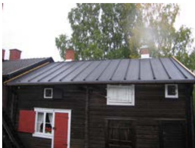
Kammare 319-320, södra fasaden efter åtgärd.
