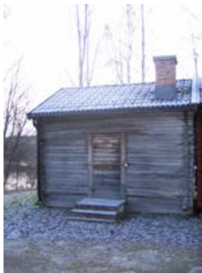
Kammare 109, norra fasaden före åtgärd.
