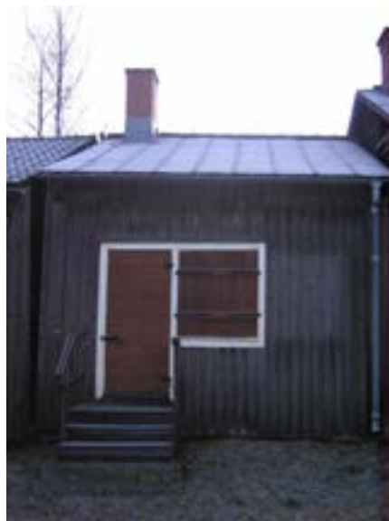
Kammare 162-163, norra fasaden före åtgärd.
