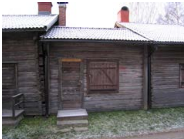
Kammare 439, norra fasaden före åtgärd.
