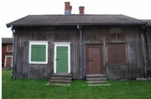
Kammare 43-46, fasad mot norr före åtgärd.
