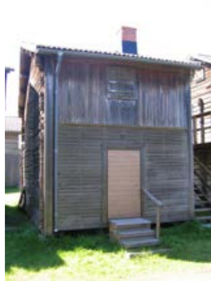
Kammare 429-430, norra fasaden före åtgärd.
