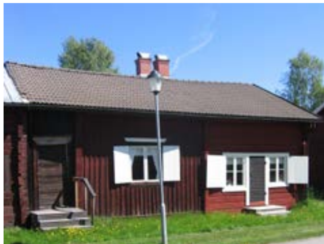
Kammare 278-281, södra fasaden före åtgärd.
