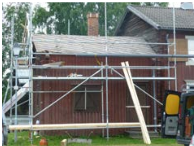
Kammare 149, masonittaket på norra takfallet under åtgärd.
