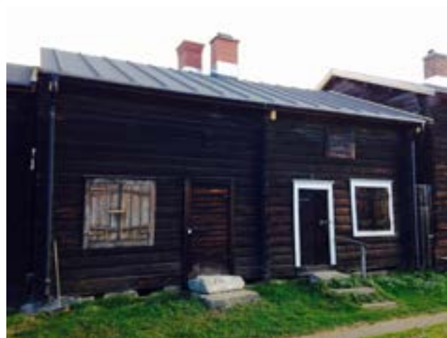
Kammare 66-69, fasad mot söder efter åtgärd.
