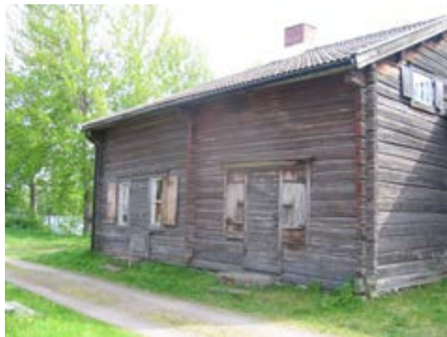
Kammare 209-212, norra fasaden före åtgärd.
