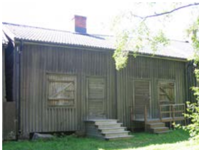
Kammare 300-303, norra fasaden före åtgärd.
