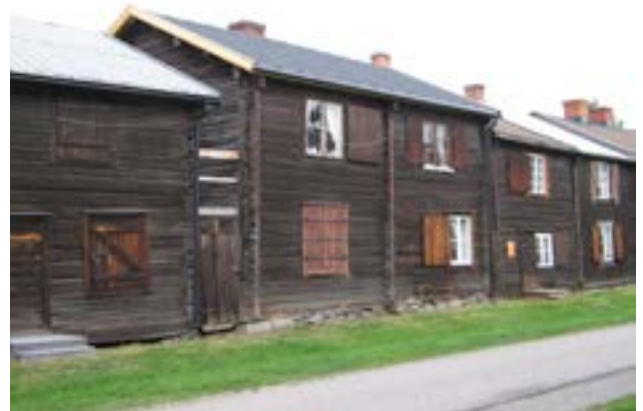
Kammare 257-260, södra fasaden efter åtgärd.
