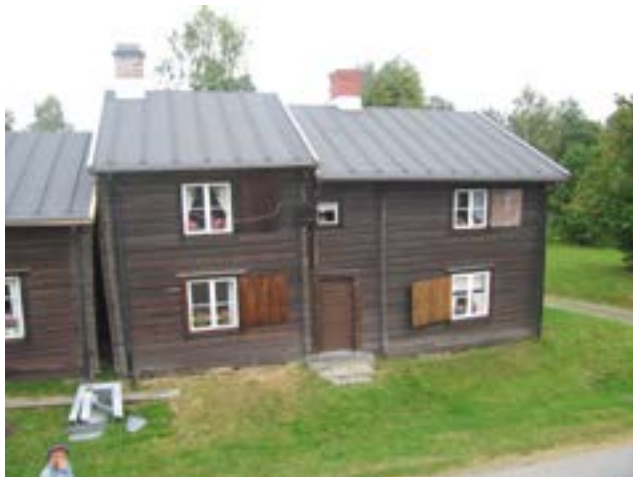
Kammare 290 och 292, södra fasaden efter åtgärd.
