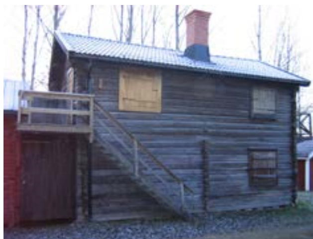
Kammare 111-114, norra fasaden före åtgärd.
