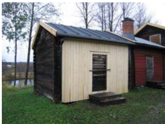
Kammare 109, norra fasaden efter åtgärd.
