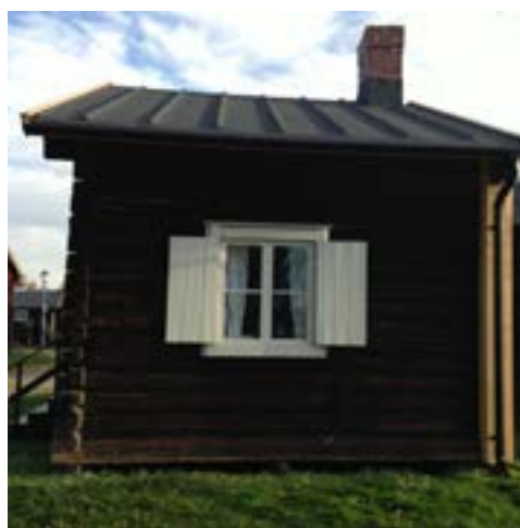
Kammare 174-175, södra fasaden efter åtgärd.
