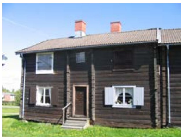
Kammare 213-220, södra fasaden före åtgärd.
