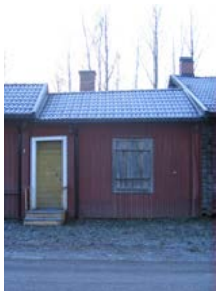
Kammare 106, norra fasaden före åtgärd.
