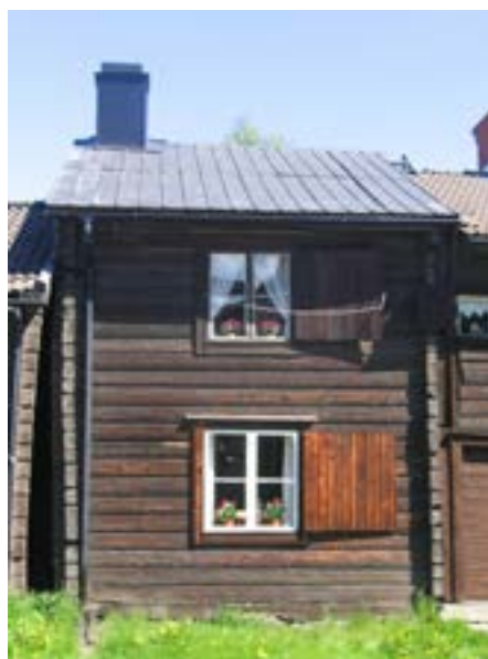
Kammare 290 och 292, södra fasaden före åtgärd.
