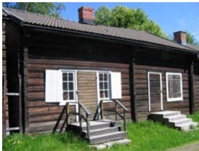
Kammare 300-303, södra fasaden före åtgärd.
