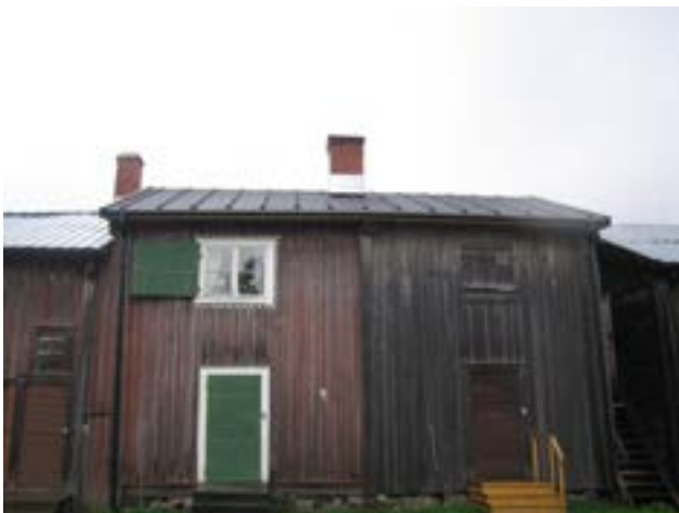
Kammare 257-260, norra fasaden efter åtgärd.
