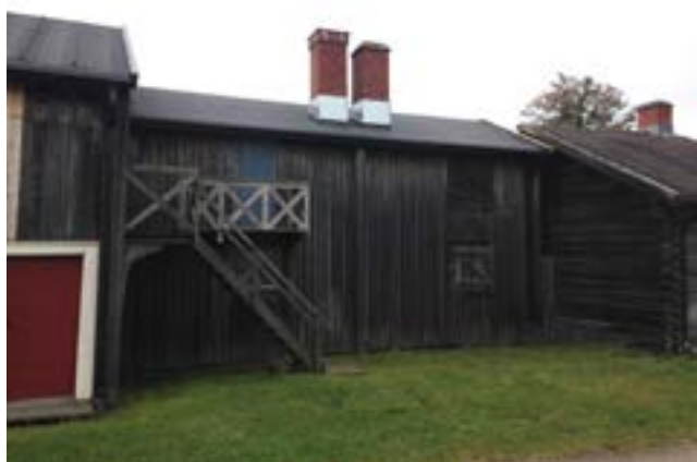
Kammare 425-428, norra fasaden efter åtgärd.
