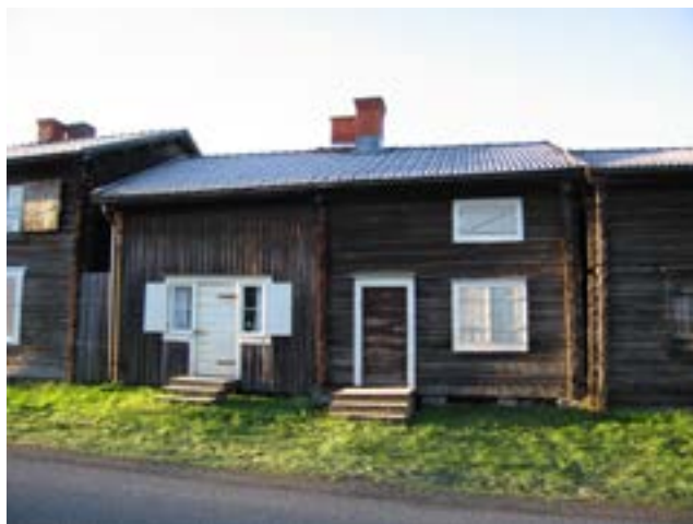
Kammare 66-69, fasad mot norr före åtgärd.
