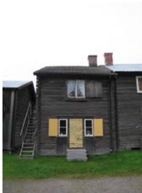
Kammare 352-355, norra fasaden före åtgärd.
