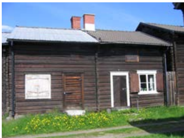
Kammare 66-69, fasad mot söder före åtgärd.
