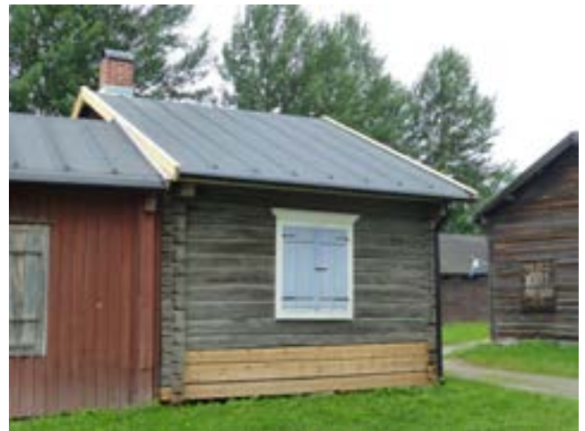
Kammare 104-105, norra fasaden efter åtgärd.
