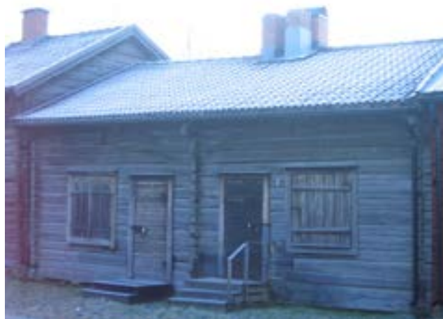
Kammare 82-85, fasad mot norr före åtgärd.
