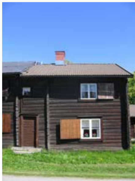
Kammare 291 och 293-295, södra fasaden före åtgärd.
