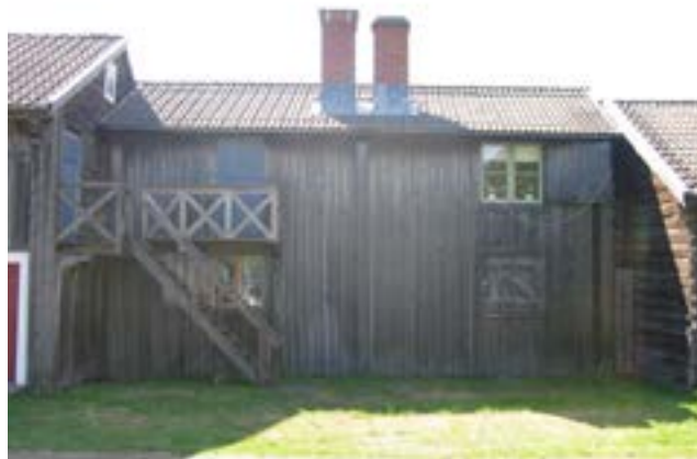
Kammare 425-428, norra fasaden före åtgärd.
