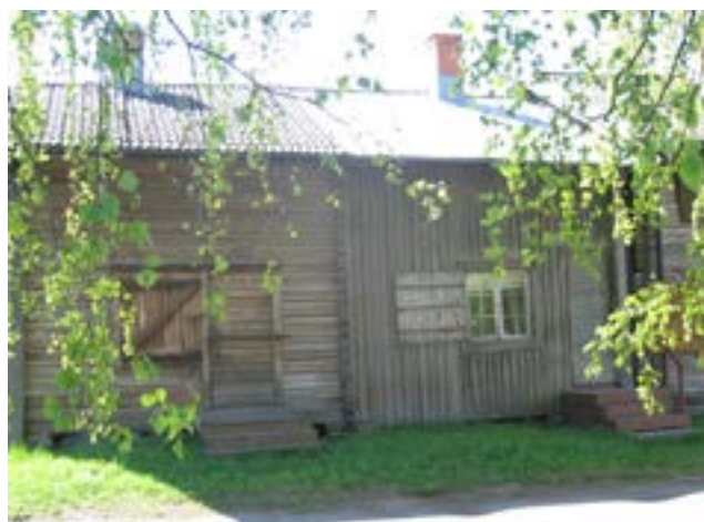
Kammare 319-320, norra fasaden före åtgärd.
