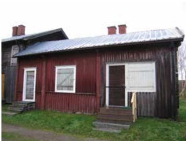
Kammare 147-148, norra fasaden före åtgärd.
