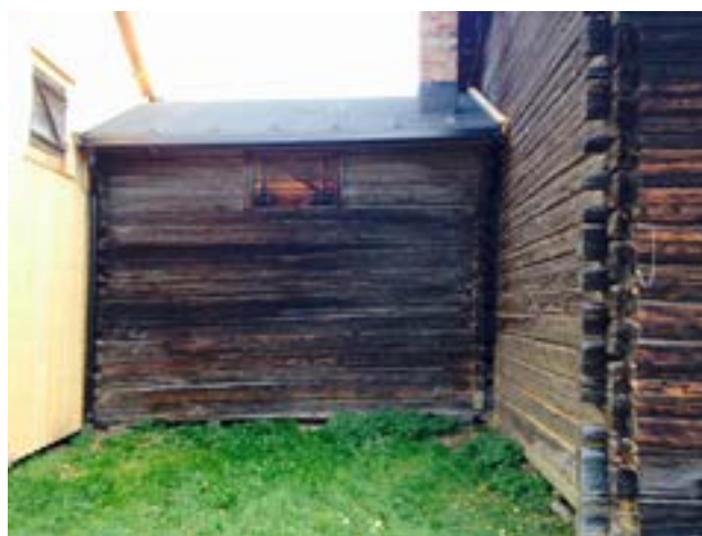
Kammare 439, södra fasaden efter åtgärd.
