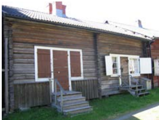
Kammare 286-289, norra fasaden före åtgärd.
