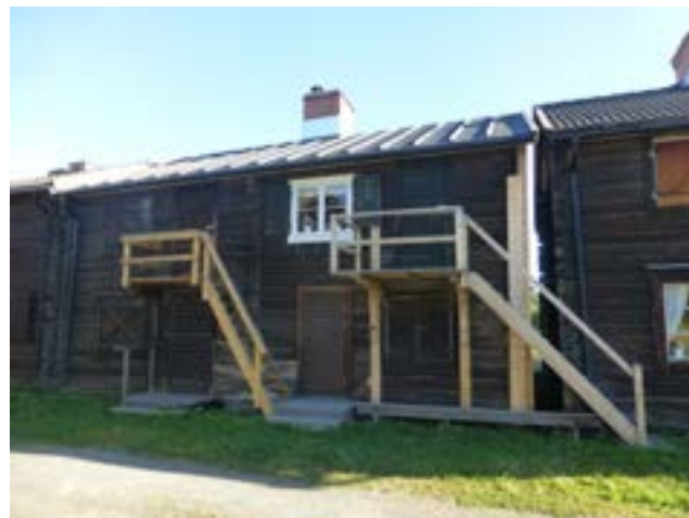
Kammare 409-416, södra fasaden efter åtgärd.
