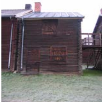
Kammare 375-378, södra fasaden efter åtgärd.
