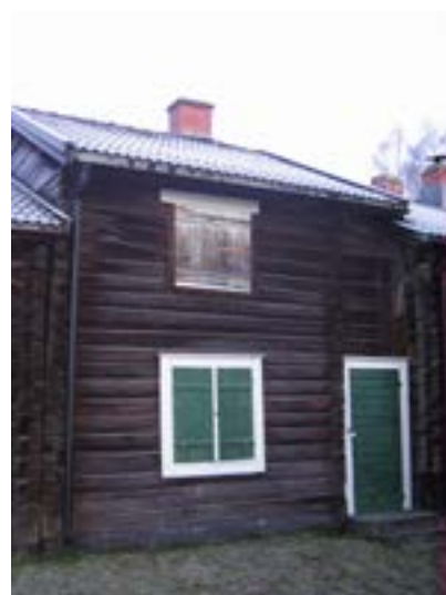
Kammare 86-89, fasad mot söder före åtgärd.
