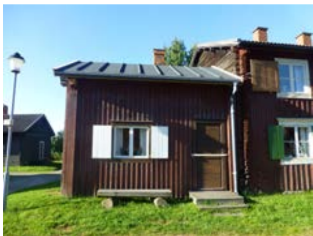
Kammare 149, norra fasaden efter åtgärd.
