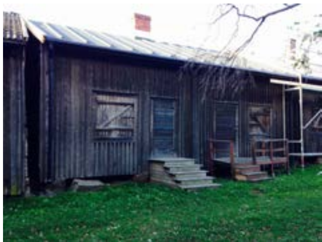
Kammare 300-303, norra fasaden efter åtgärd.
