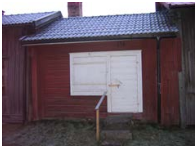
Kammare 136, norra fasaden före åtgärd.
