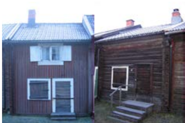
Kammare 90 och 92, norra och södra fasaden före åtgärd.
