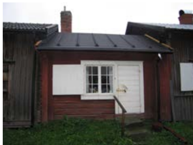
Kammare 136, norra fasaden efter åtgärd.
