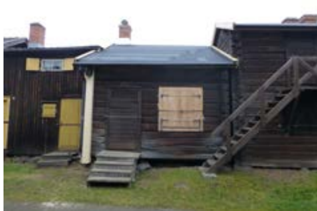
Kammare 431-432, södra fasaden efter åtgärd.
