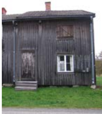
Kammare 17-20, fasad mot norr före åtgärd.
