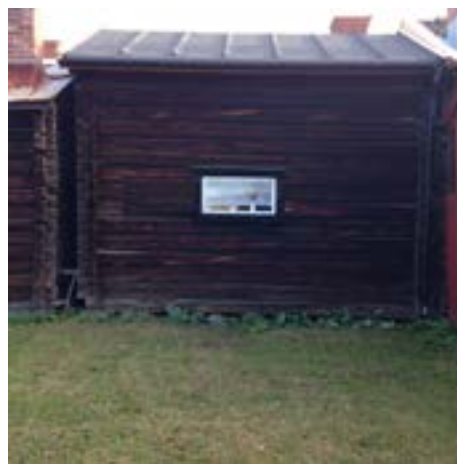
Kammare 127, södra fasaden efter åtgärd.
