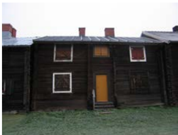
Kammare 237-244, södra fasaden efter åtgärd.
