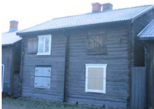
Kammare 70-73, fasad mot norr före åtgärd.
