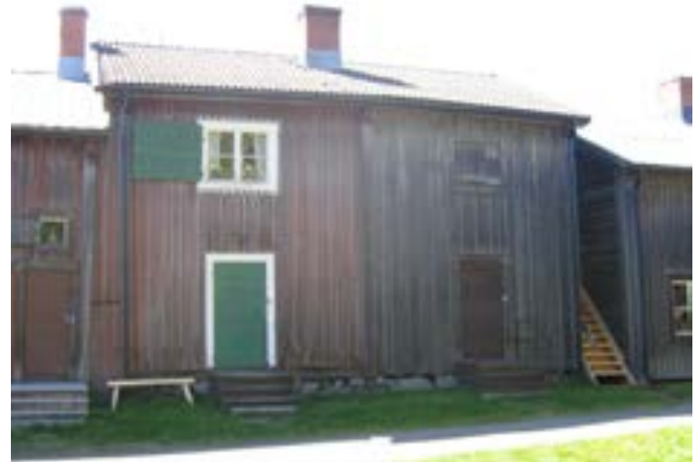
Kammare 257-260, norra fasaden före åtgärd.
