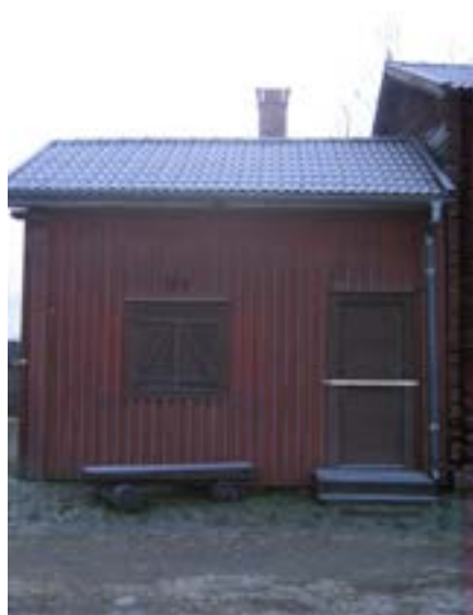
Kammare 149, norra fasaden före åtgärd.
