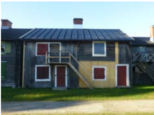
Kammare 409-416, norra fasaden efter åtgärd.
