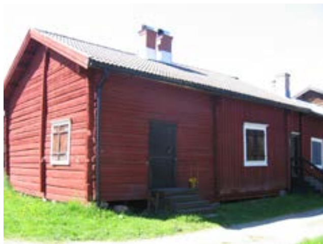
Kammare 278-281, norra fasaden före åtgärd.
