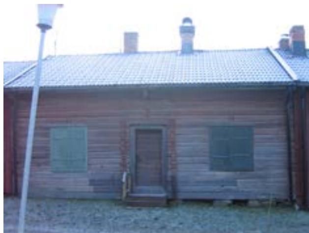
Kammare 93-96, norra fasaden före åtgärd.
