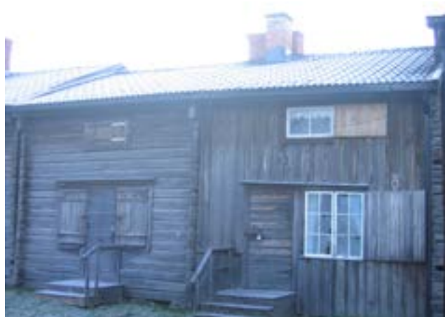
Kammare 62-65, fasad mot norr före åtgärd.
