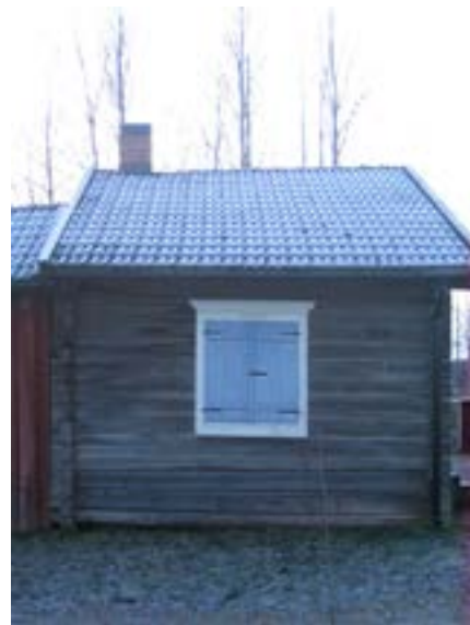
Kammare 104-105, norra fasaden före åtgärd.
