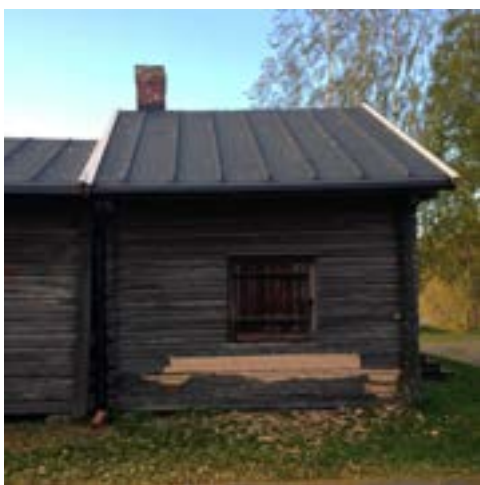
Kammare 174-175, norra fasaden efter åtgärd.
