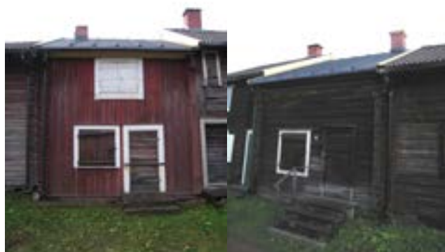
Kammare 90 och 92, norra och södra sidan efter åtgärd.
