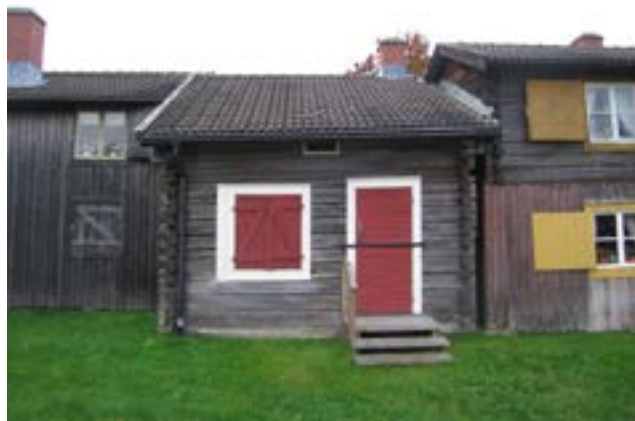
Kammare 431-432, norra fasaden före åtgärd.
