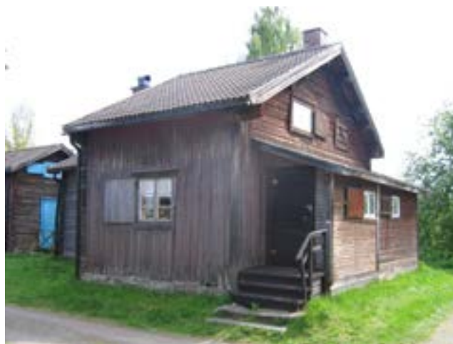
Kammare 203-204, norra fasaden före åtgärd.
