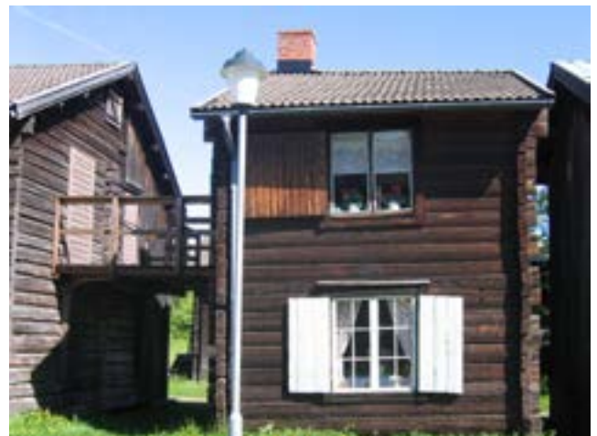
Kammare 429-430, södra fasaden före åtgärd.
