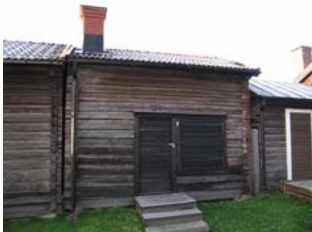
Kammare 127, norra fasaden före åtgärd.
