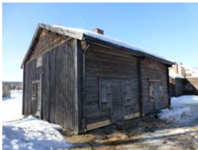
Kammare 209-212, norra fasaden efter åtgärd.
