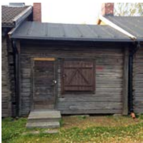
Kammare 439, norra fasaden efter åtgärd.
