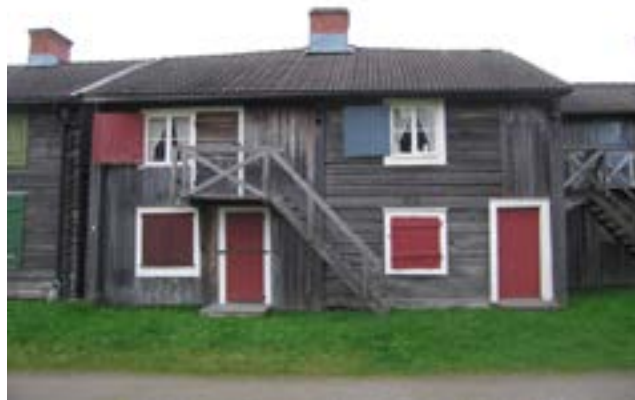
Kammare 409-416, norra fasaden före åtgärd.
