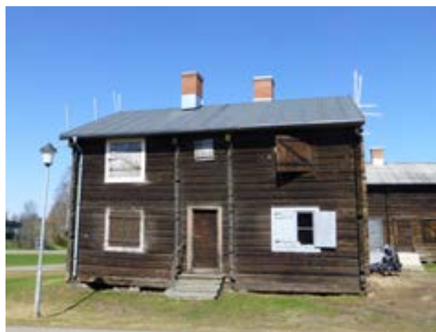
Kammare 213-220, södra fasaden efter åtgärd.
