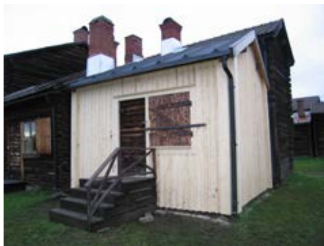
Kammare 200, södra fasaden efter åtgärd.
