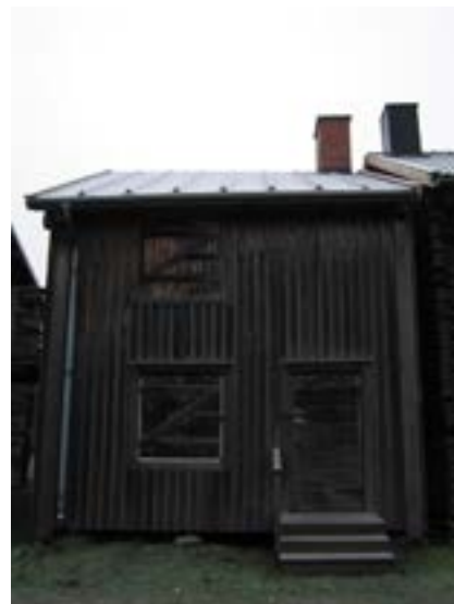
Kammare 375-378, norra fasaden efter åtgärd.
