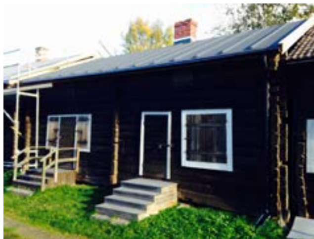
Kammare 300-303, södra fasaden efter åtgärd.
