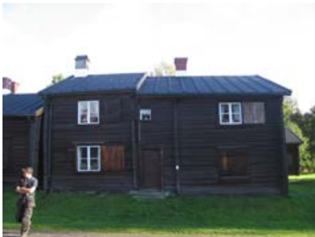
Kammare 291 och 293-295, södra fasaden efter åtgärd.
