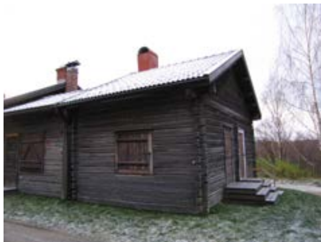
Kammare 174-175, norra fasaden före åtgärd.
