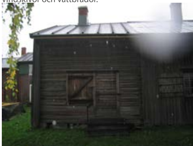
Kammare 319-320, norra fasaden efter åtgärd.
