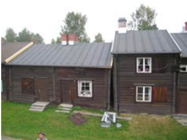
Kammare 286-289, södra fasaden efter åtgärd.
