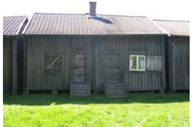
Kammare 304-307, norra fasaden före åtgärd.
