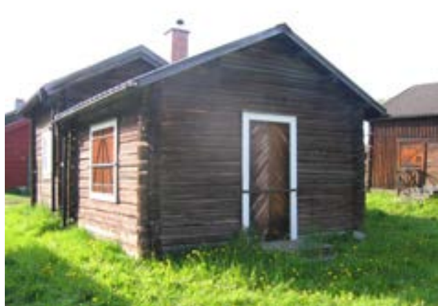
Kammare 437B, östra fasaden före åtgärd.
