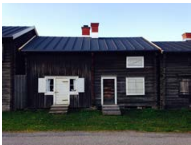
Kammare 66-69, fasad mot norr efter åtgärd.
