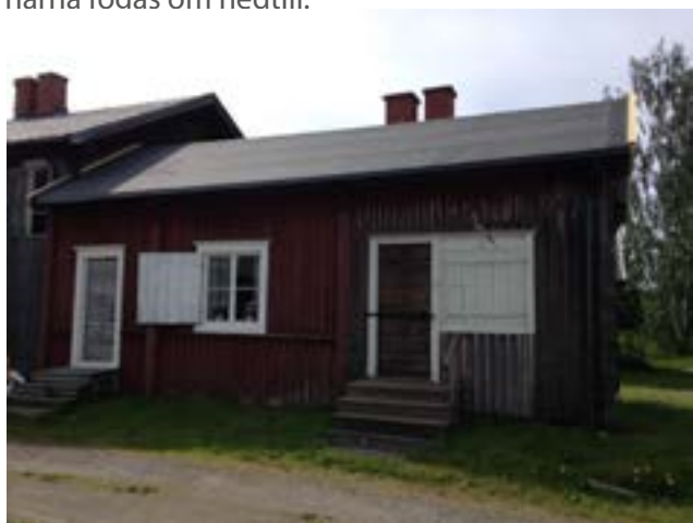
Kammare 147-148, norra fasaden efter åtgärd.
