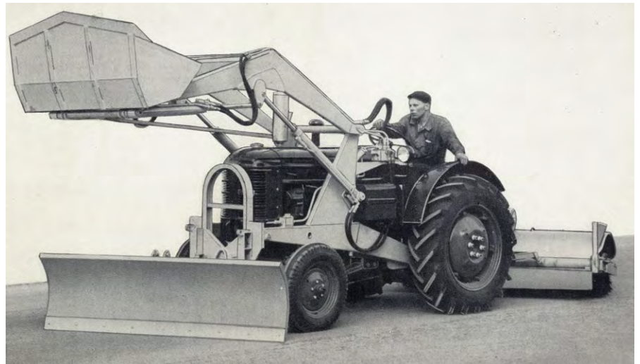
Bilden visar en Volvo T 25 utrustad med schaktblad, fronlastare och sopvals.
