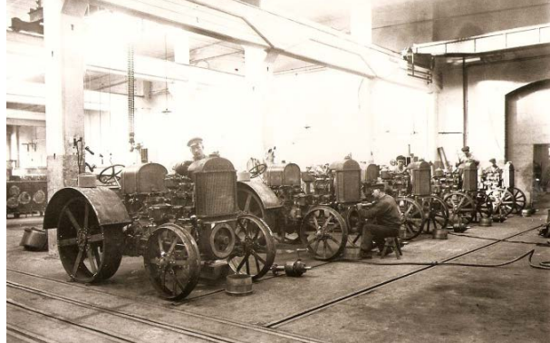
Här en bild som visar monteringen av 22 hk och 30 hk Motortraktor.
