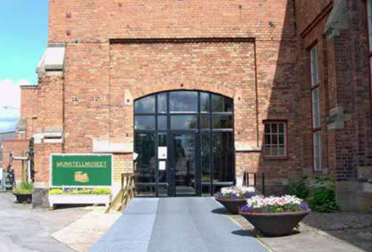
Nya entrén byggd.
